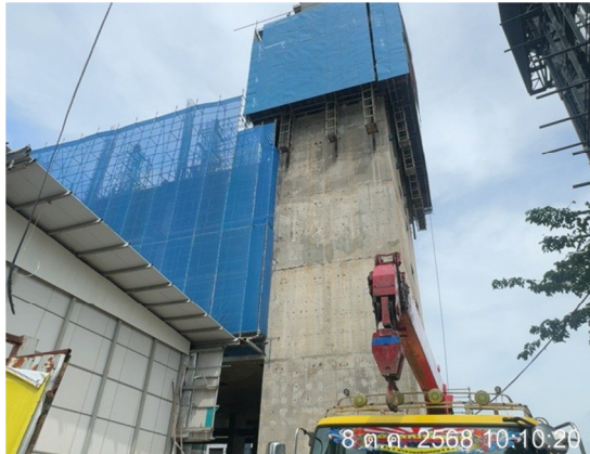
ภาพที่ 6 ติดตั้ง Mesh Sheet ตลอดความสูงของอาคาร
