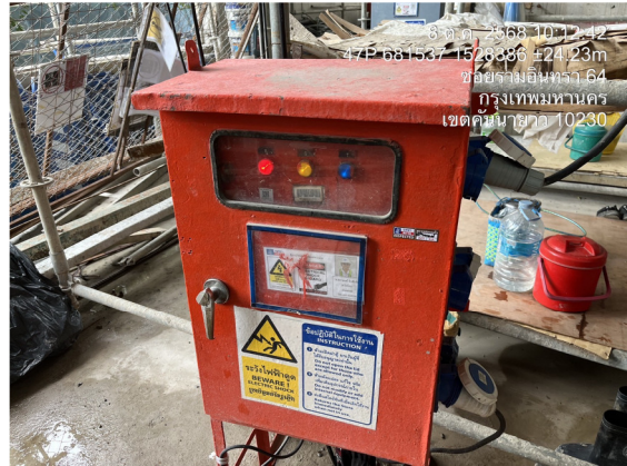
ภาพที่ 24 ตู้กระจายไฟฟ้าในพื้นที่ก่อสร้าง
